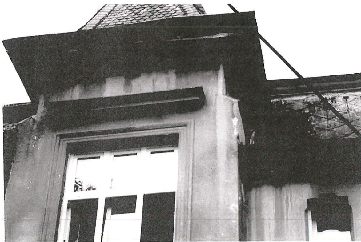
4. Widok elewacji budynku od strony wschodniej stolarka okienna wymieniona na nową, widoczny łupek na dachu i wieżyczce kwalifikuje się do wymiany.
