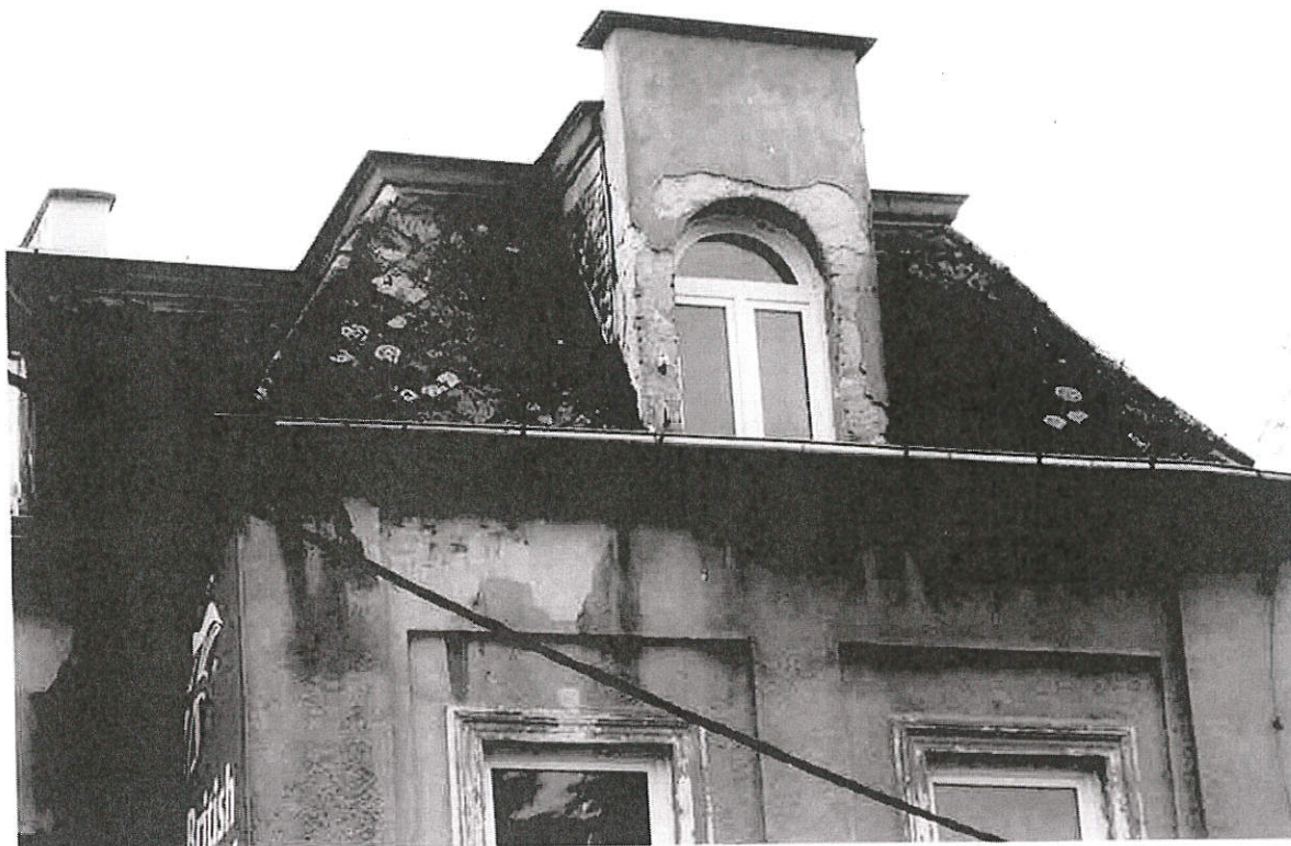
3. Widok elewacji budynku od strony północnej elewacja wymaga odbicia głuchych tynków, uzupełnienia tynków, pokrycie dachowe z łupka zużyte wiekowo kwalifikuje się do wymiany.
