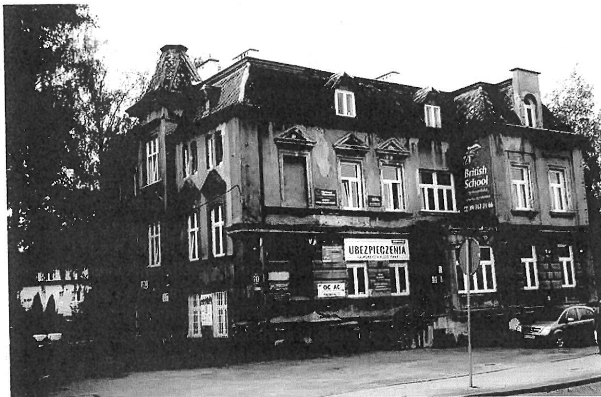
1. Widok budynku od strony północno-wschodniej, elewacja budynku wymaga remontu, reklamy i tablice informacyjne szpecą elewację, pokrycie łupkiem dachu do wymiany
