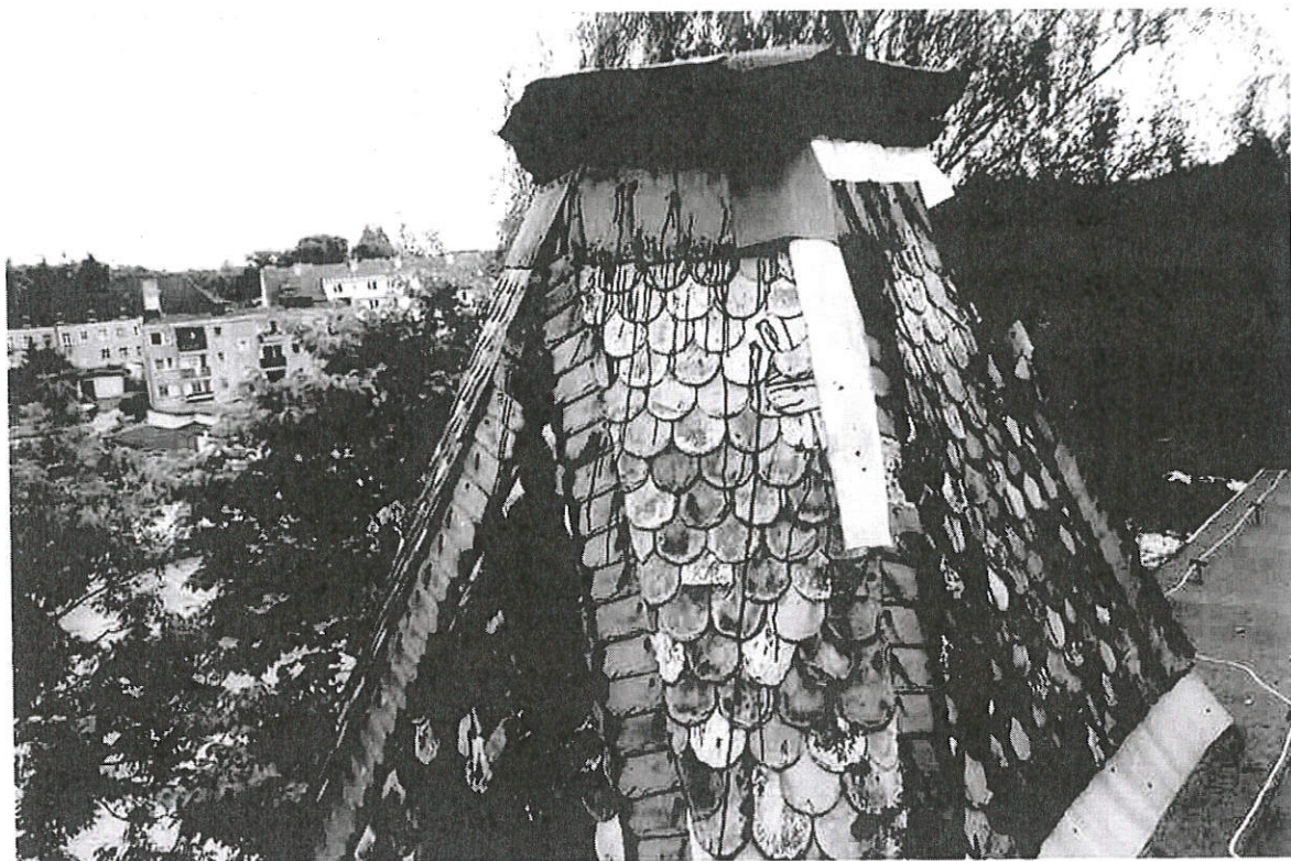
11. Widok wieżyczki pokrytej łupkiem wymaga wymiany pokrycia, obróbkę blacharskich, wymiany elementów konstrukcyjnych, zamontować zdemonstowaną latarnkę.
