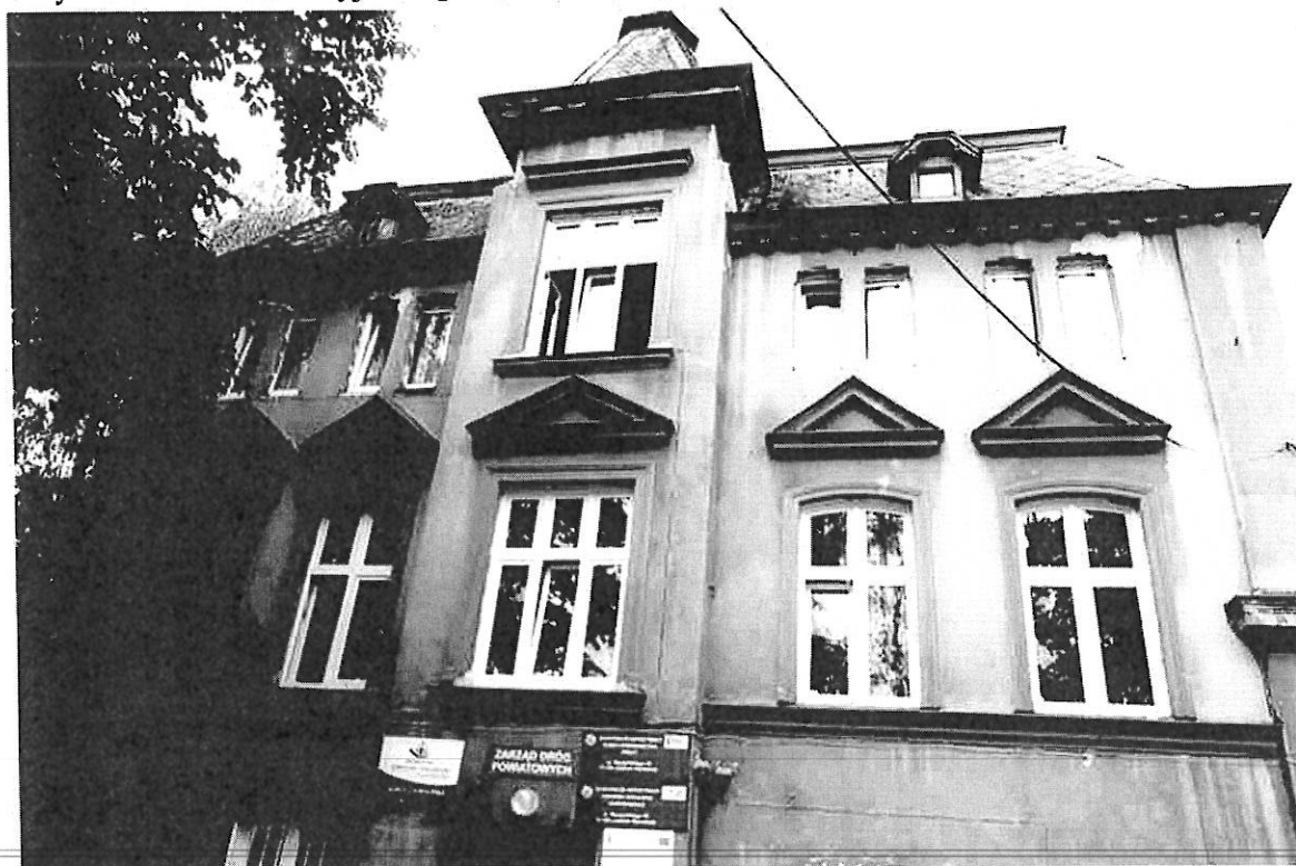
2. Widok budynku od strony wschodniej stolarka okienna wymieniona na nową, remontu lub wymiany wymagają okna w lukarnach na poddaszu..
