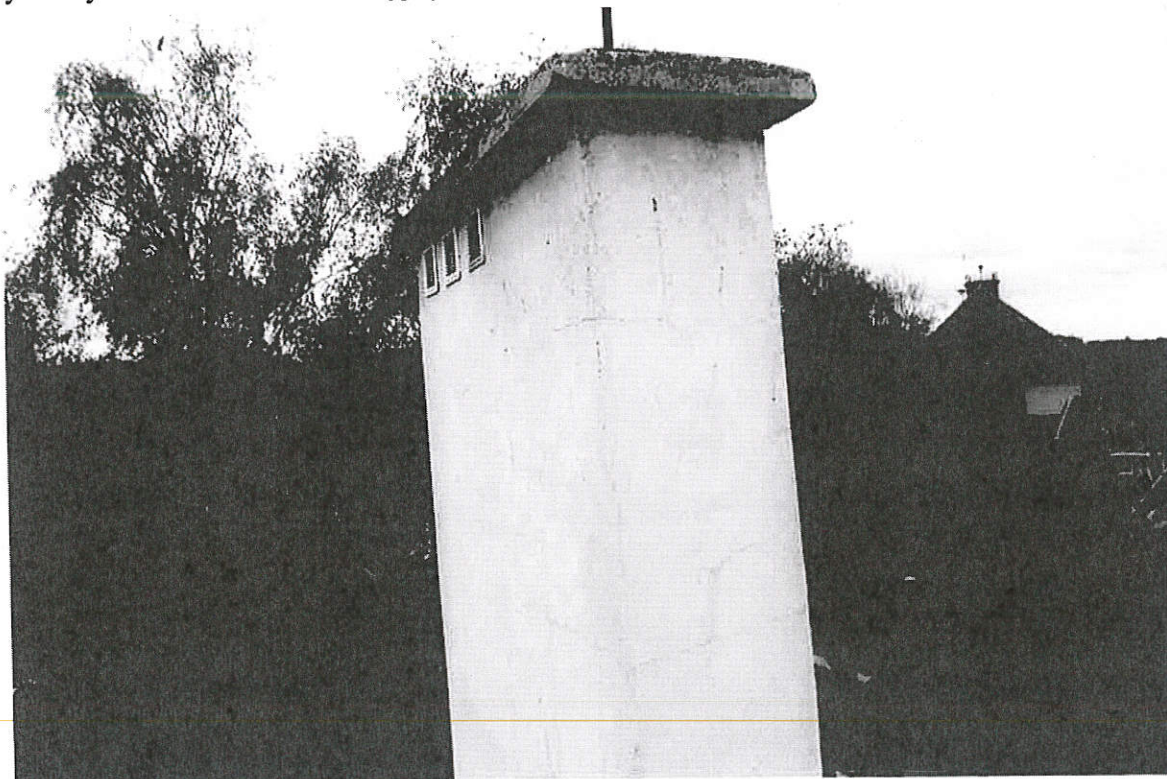
12. Widok komina dymowego wymaga dostosowania komina do wentylacji zlikwidować, wyremontować zarysowania tynku na kominie.
